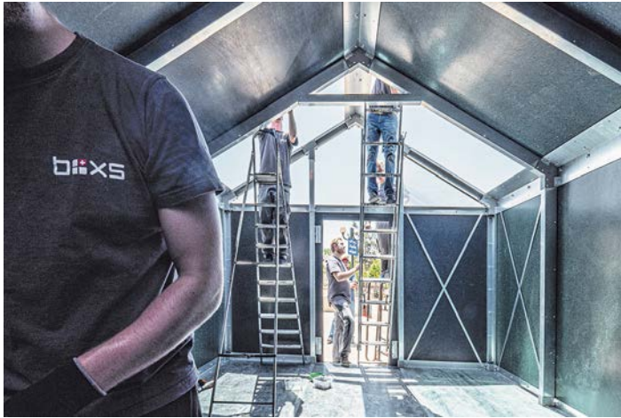
Die Boxs AG hat aus Plastikabfall ein Raumsystem für den Einsatz in Entwicklungsländern entwickelt.
